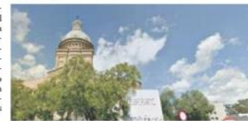
La reforma de la cúpula està pendent des de fa molts anys. Foto: Google Maps
